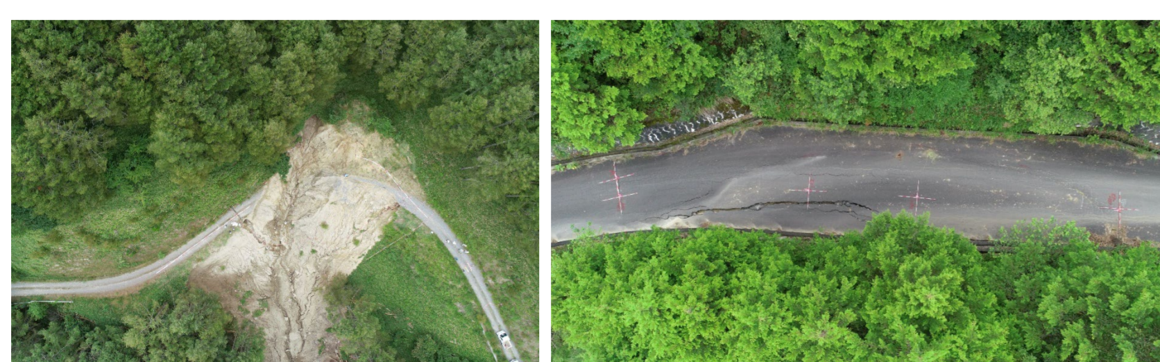
図6 抽出された箇所・されない箇所の一例
